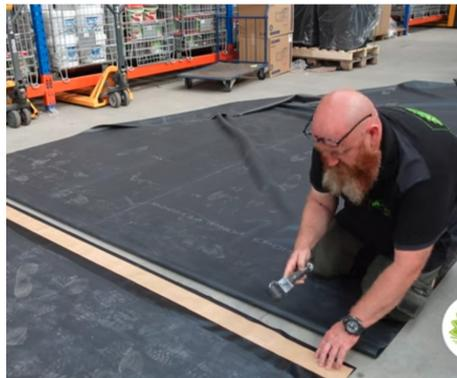
Et alors on va bien pousser sur la bande de caoutchouc non vulcanisée en veillant à ne pas trop déplacer la bâche et toujours travailler d'abord de façon perpendiculaire à la pose :
