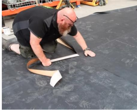
La soudure va se faire exactement à l'endroit du tape. La partie qui est ici va tenir mais le gros de la soudure va tenir où on a fait la mise en place du tape.
